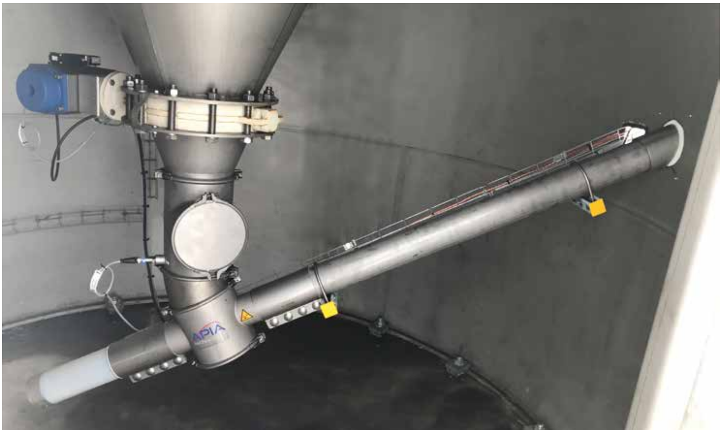
| Reprise sous silo conforme ATEX.
