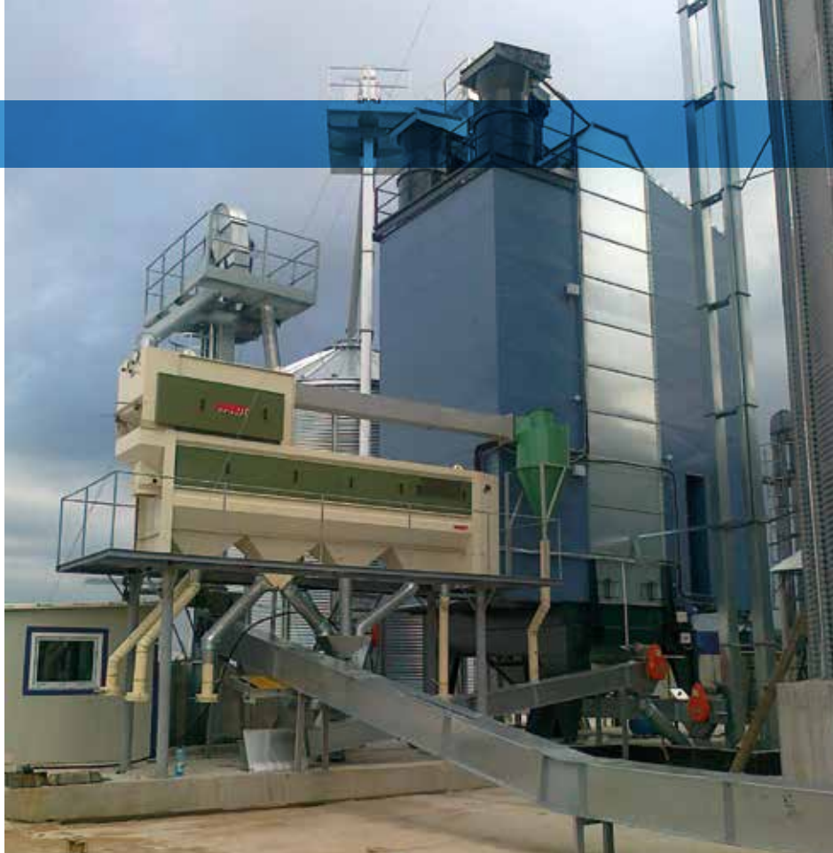
| Installation réalisée par CFCAL en Roumanie.
