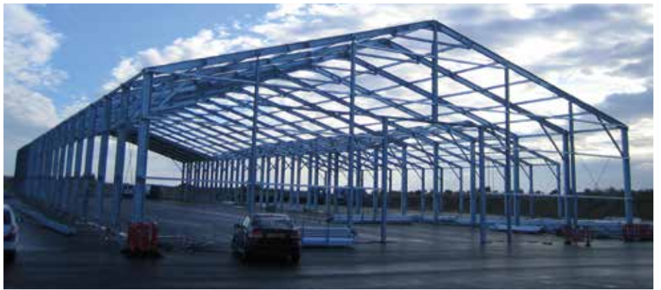
| Bâtiment modulaire en cours de montage.
