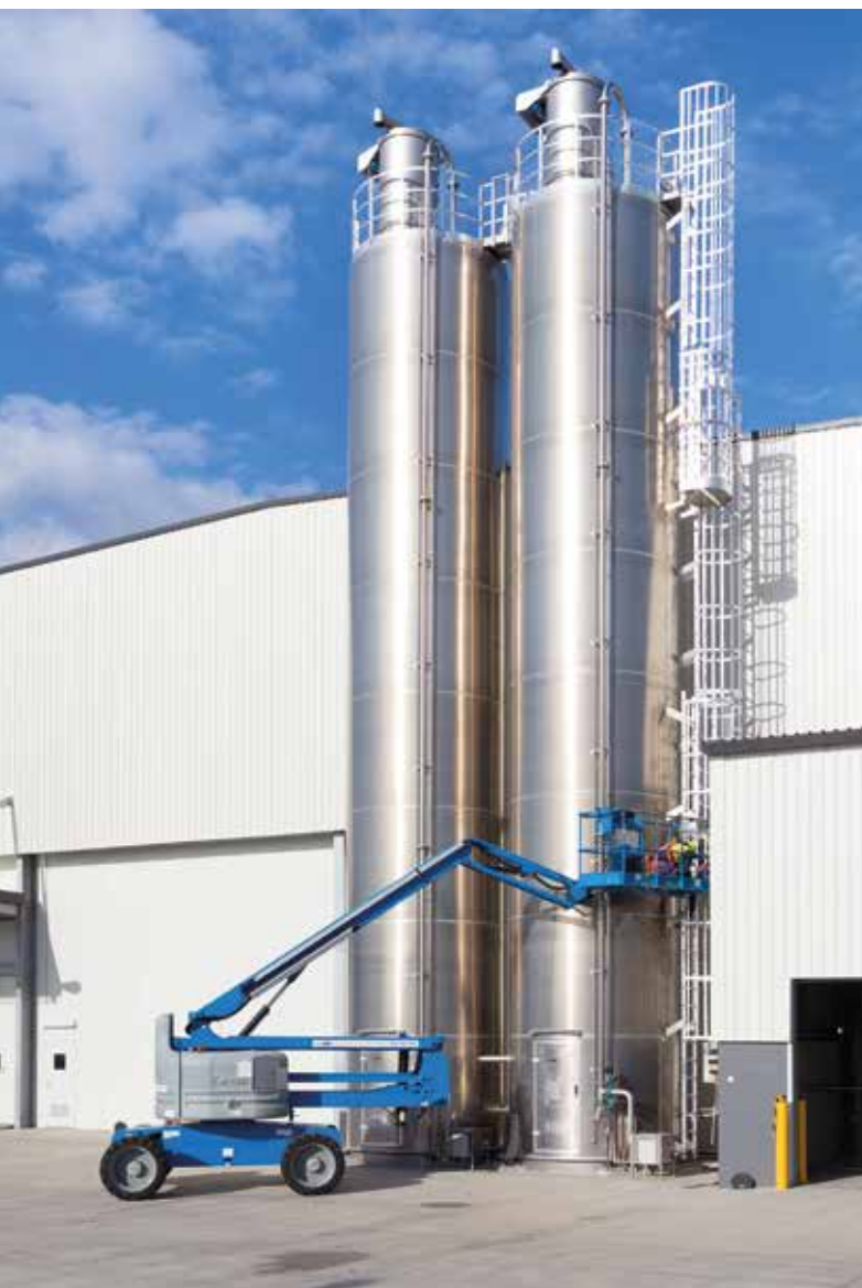
| Silos de 85 m 3 pour le stockage des farines.
