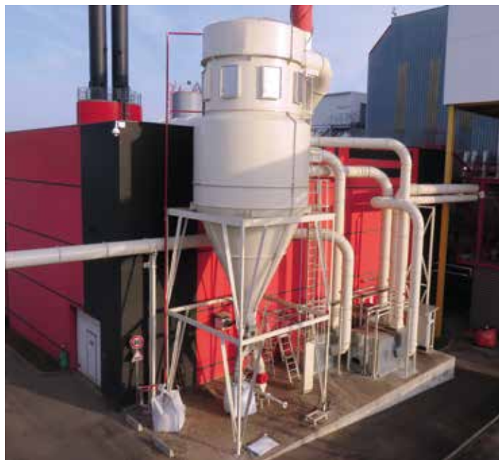
Études et réalisation d'une installation de dépoussiérage avec système ATEX pour une chaufferie biomasse.
