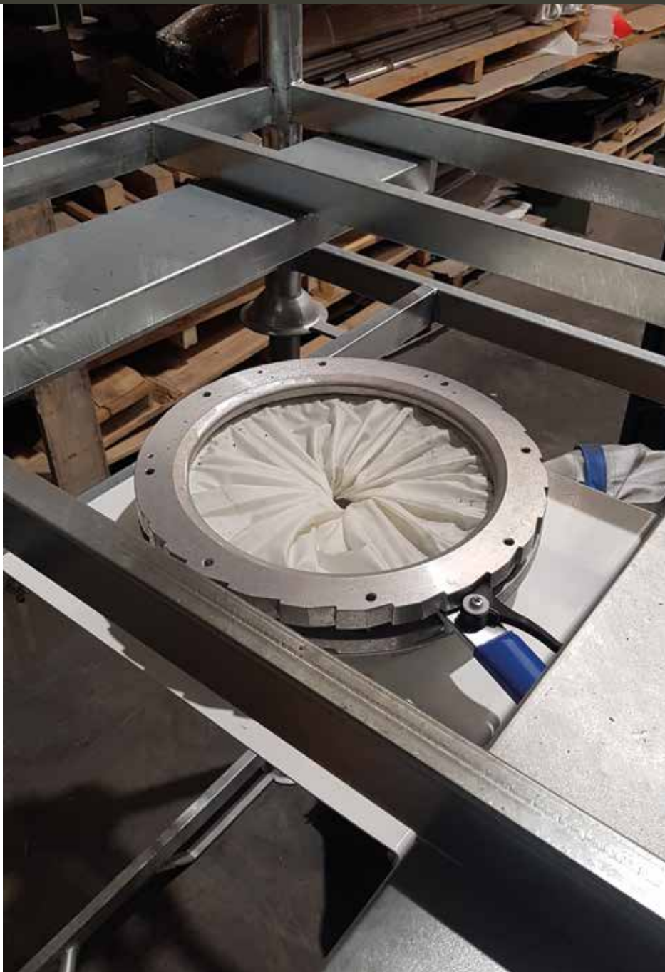
Station de vidange équipée d'une vanne à diaphragme.
