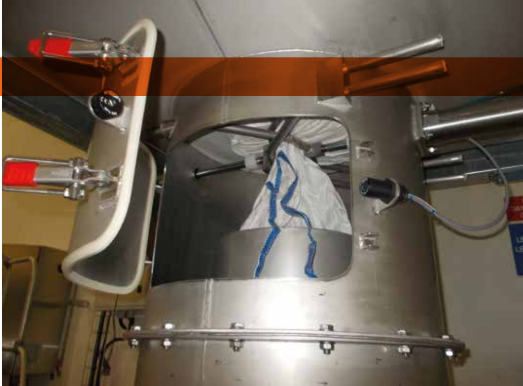
Zoom sur la porte étanche du sas de sécurité.
