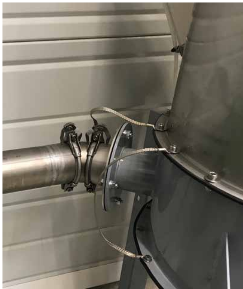
Zoom sur les raccords et tresse de mise à la terre.
